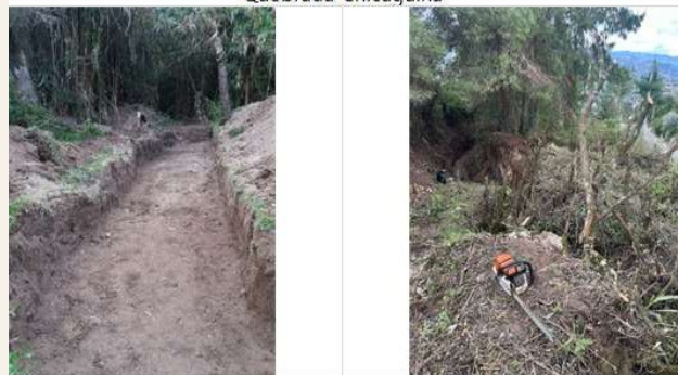
Quebrada Huayrapata Alto Tramo 1
